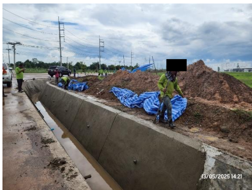
งานก่อสร้างวางระบายน้ำฝนของโครงการ
